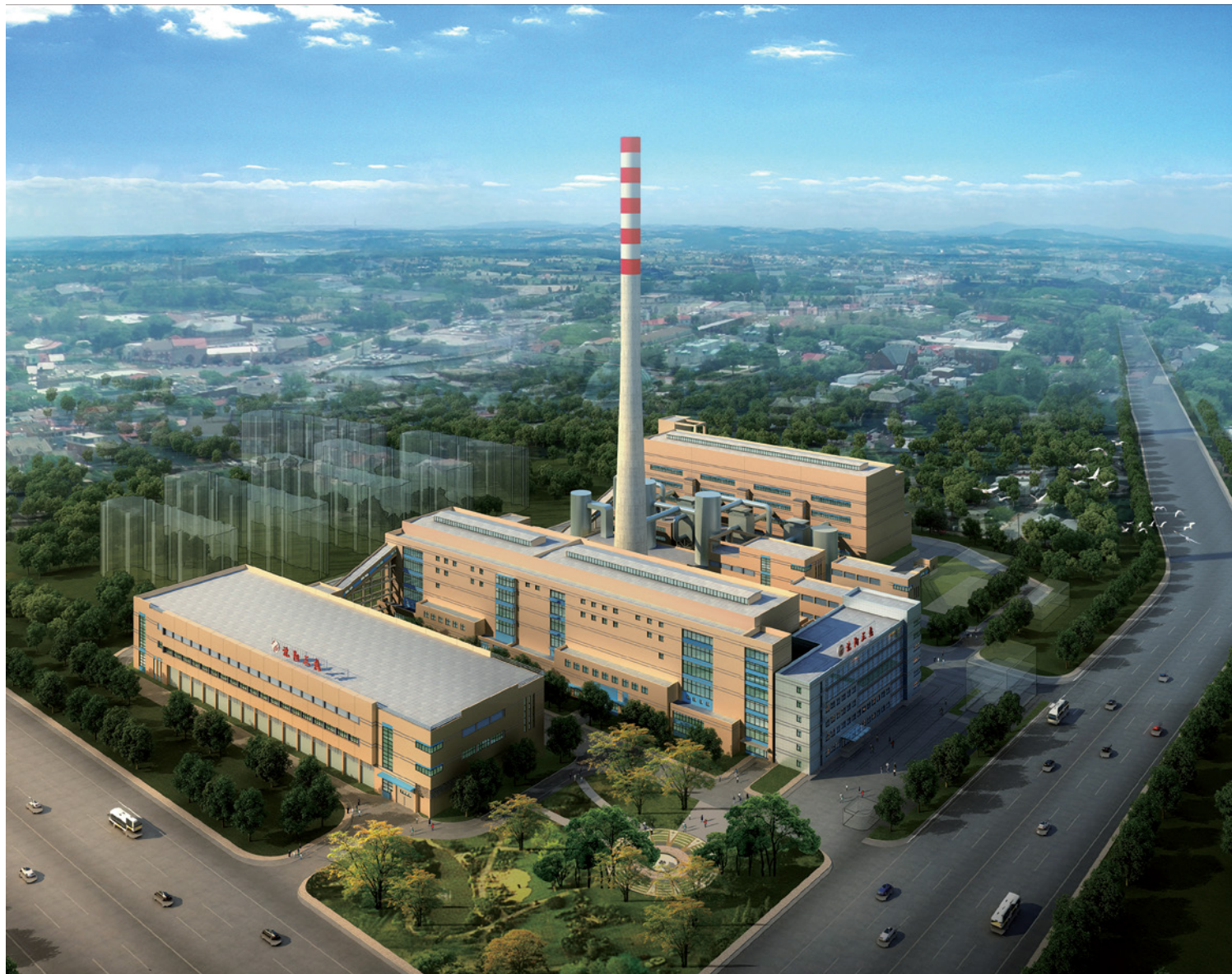
项目名称：沈阳第三热力供暖有限公司珠江热源厂三期工程 项目规模：5台91MW燃煤热水锅炉 建设时间：2014年
