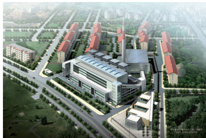
项目名称：北京顺义城东供热中心 项目规模：5台64MW燃煤热水锅炉 建设时间：2008年
