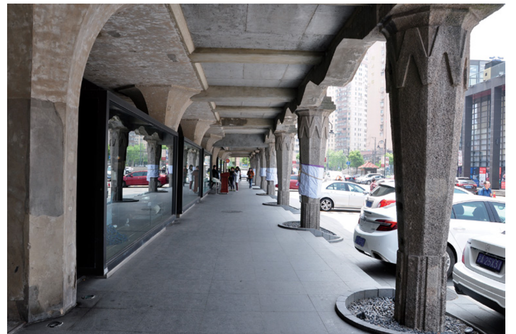
玻璃幕墙与实体墙对比
