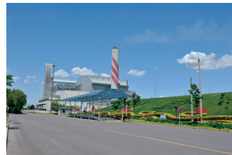
北京东北热电中心高安屯电厂
