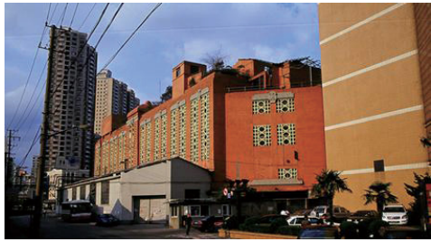
城市风貌整顿时粉刷的外立面
