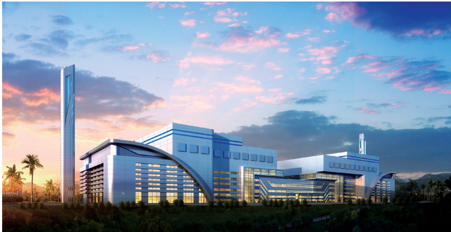
项目名称：广州东部固体资源再生中心——广州市第三资源热力电厂 建设规模：日处理垃圾量4000吨，安装6×750/d机械炉排焚烧炉+4×25MW凝气式发电机组 建设时间：2014年
