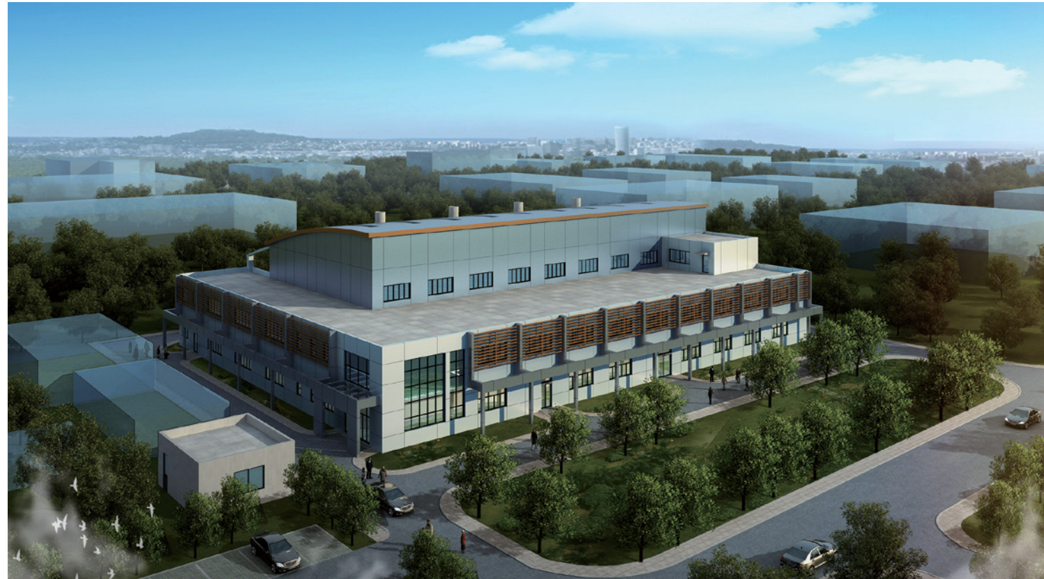
项目名称：北京经济技术开发区东工业区锅炉房煤改气工程 项目规模：4台29MW燃气热水锅炉 建设时间：2014年
