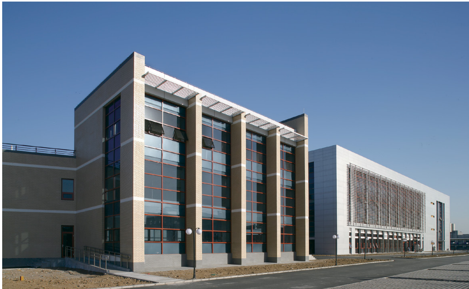
项目名称：北京经济技术开发区3号供热厂 项目规模：6台35MW燃气蒸汽锅炉 建成时间：2007年
