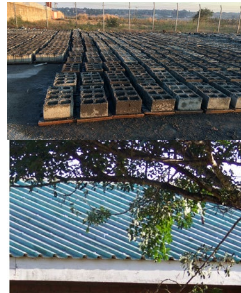
当地企业自制混凝土砌块及当地的金属屋面
