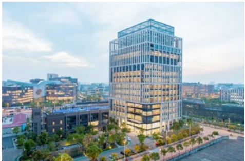
盛大网络中心办公楼
